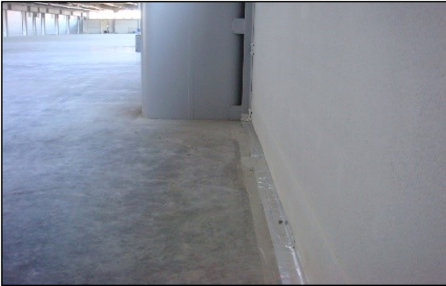
【ソーカンパックALタイプ 施工例】 ※倉庫案件
